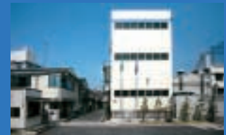
Central Plant (Aichi Prefecture, Japan) 本社工場
