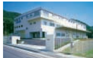
No. 2 Kakamihigashimachi Plant (Gifu Prefecture, Japan) 各務東町工場第二棟(岐阜県)
